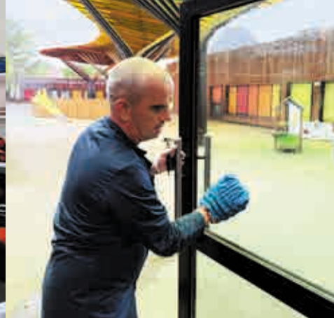
Réfection de la salle des maîtres et de stockage des jeux extérieurs à l'école Cocheris.
