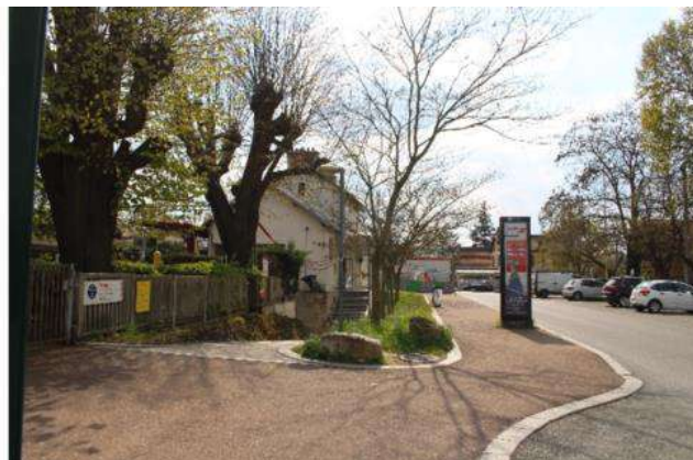
Bâtiment de la gare de Sainte-Geneviève-des-Bois
