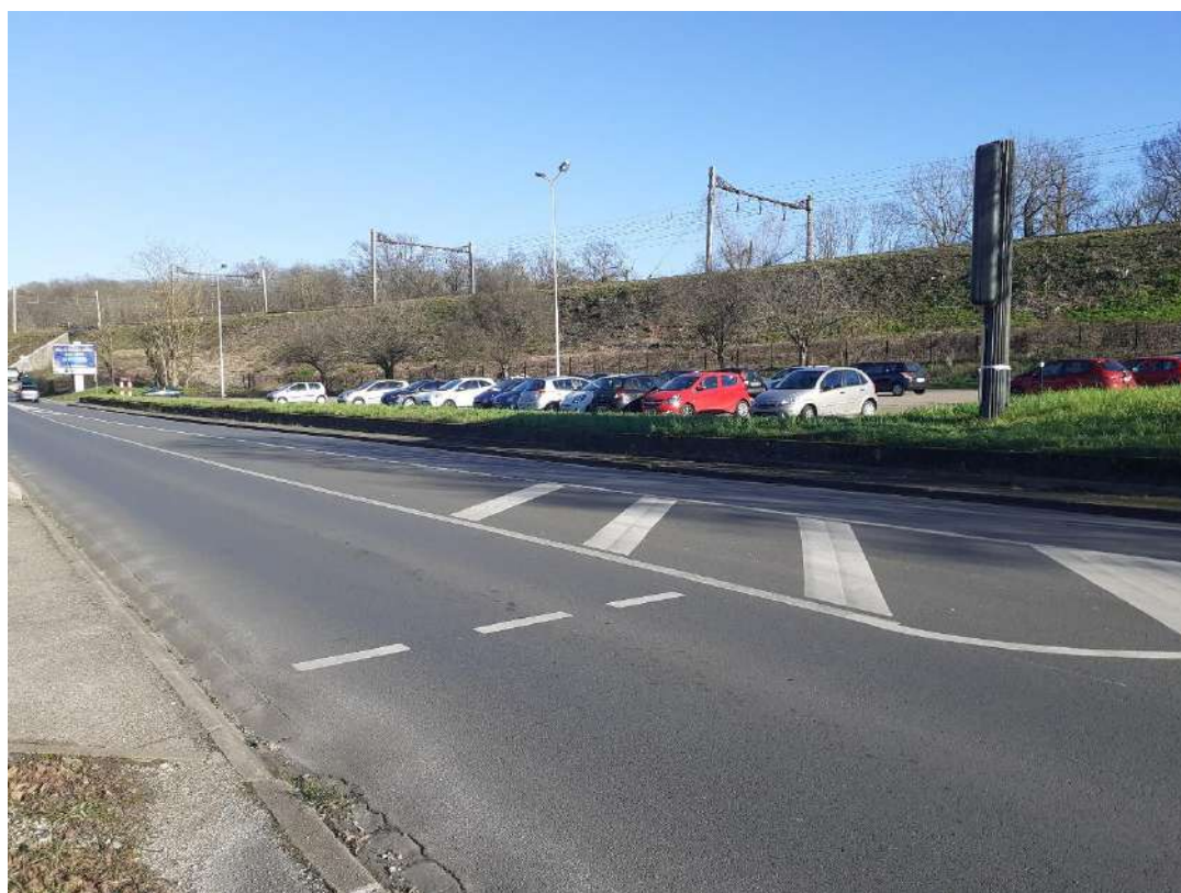
Photographie 4 : Vue du parking nord
