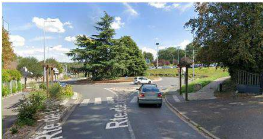
Figure 92 : Photo du giratoire de l'intersection entre la RD25 et la RD35
