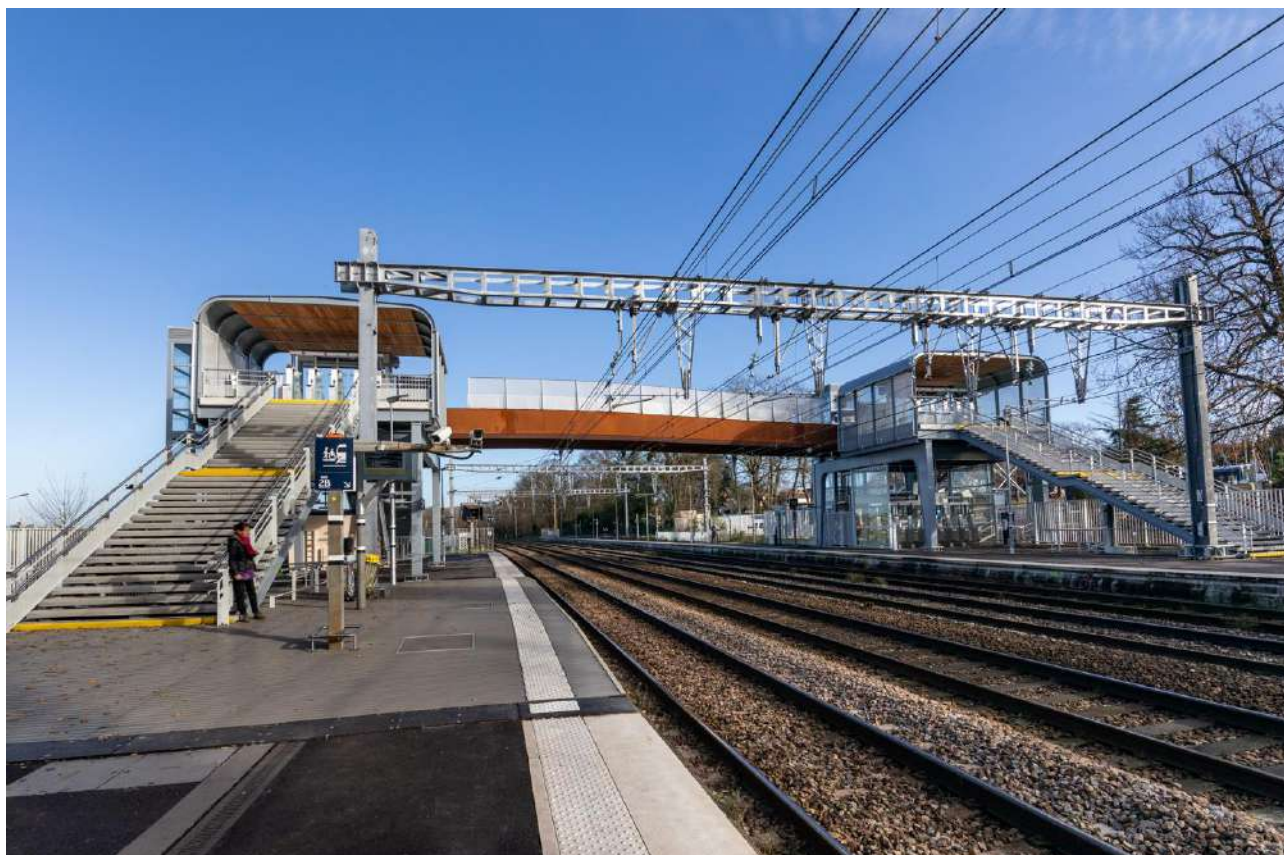
Figure 107 : Vue sur la passerelle depuis le quai
