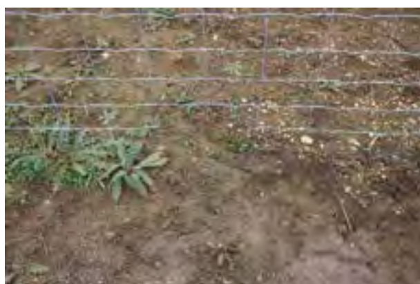
Exemple de passages créés par découpe de la clôture garantissant sa perméabilité à la petite faune
