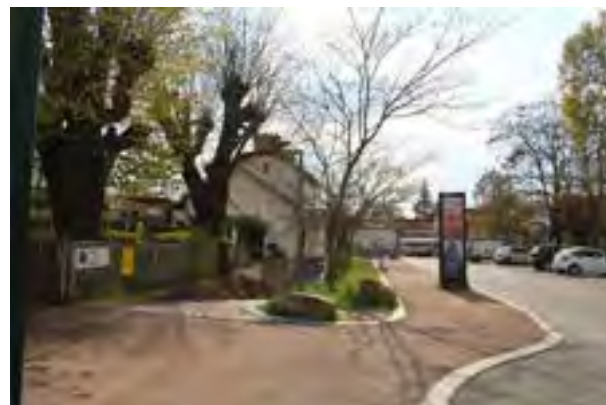
Bâtiment de la gare de Sainte-Geneviève-des-Bois
