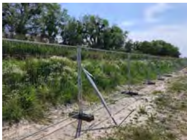
Exemple de clôture Héras mise en œuvre sur un chantier pour préserver des habitats naturels
