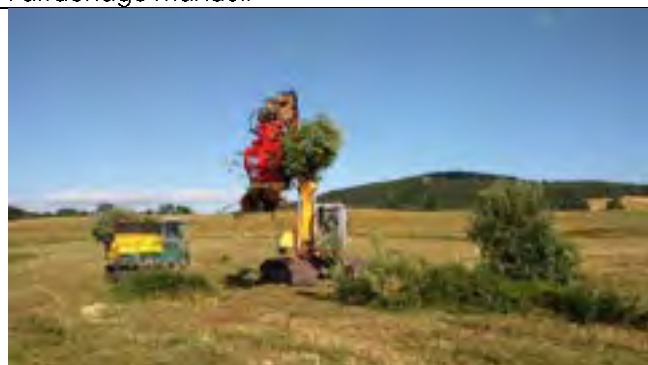
Exemple d'arrachage mécanique (en site naturel) à la pince sur pelleteuse
