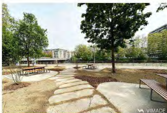
PAV Pointe Nord, Genève (CH). Vimade, Materium. Réemploi des croûtes d'enrobé et conservation de parties de l'enrobé existant. © Vimade
