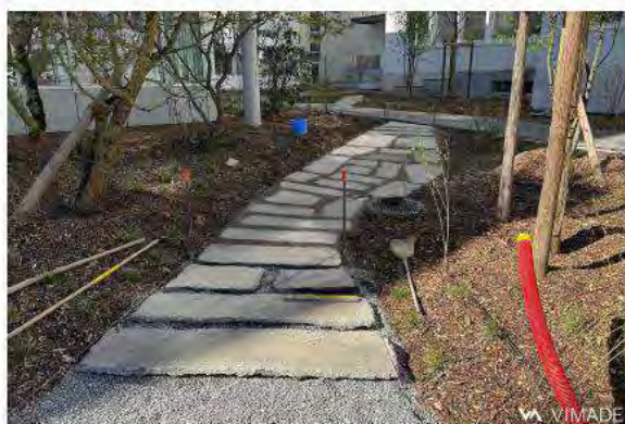
PAV Pointe Nord, Genève (CH). Vimade, Materium. Réemploi des croûtes d'enrobé et conservation de parties de l'enrobé existant. © Vimade
