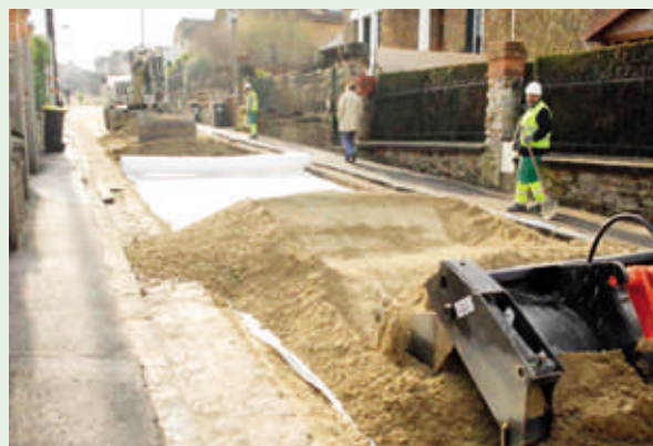
Pose de ralentisseur sur la rue FH Manhès
