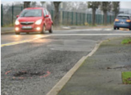
Les nids de poule sont ces trous dans la chaussée qui peuvent s'avérer dangereux, voire très dangereux pour les deux roues. Dès que la Ville en repère, le service voirie intervient pour les combler en injectant un matériau provisoire. Il est important de réagir rapidement pour éviter la désagrégation de la chaussée. Il revient ensuite à Cœur d'Essonne Agglomération, qui détient la compétence de la voirie, de réaliser la réparation définitive.
