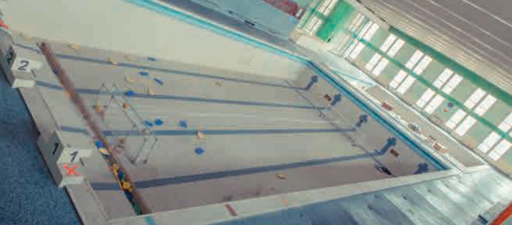
Bassin de l'ancienne piscine
